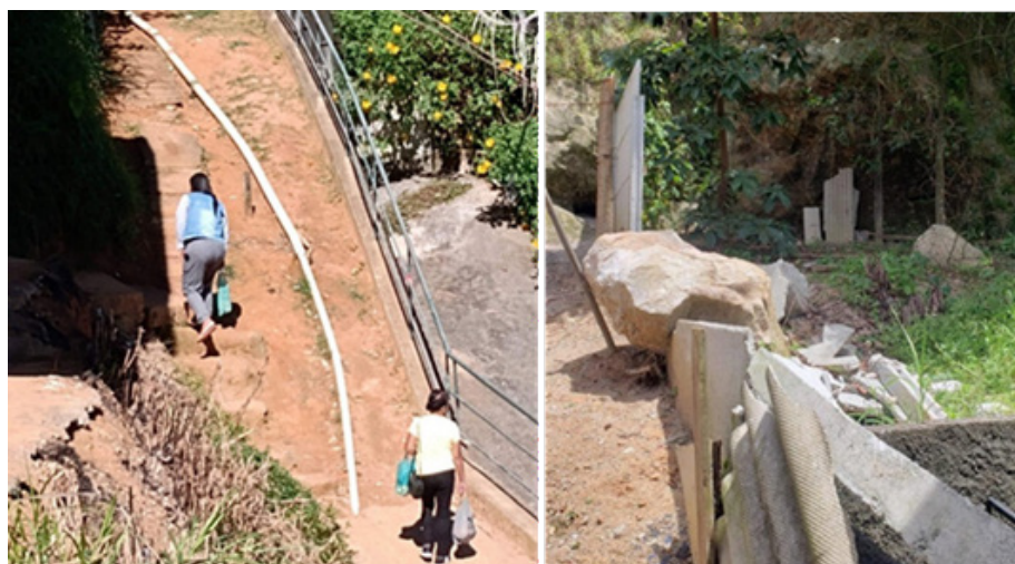
Figura 2 Escadaria sem calçamento ou apoios e escombros de deslizamentos anteriores.
