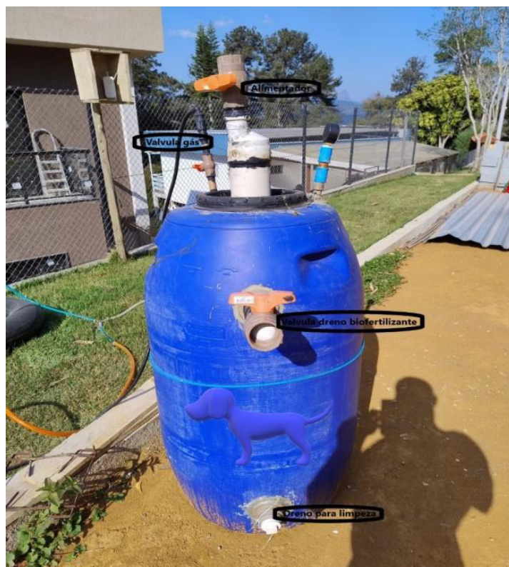
Figura 3 - Foto do Biodigestor
