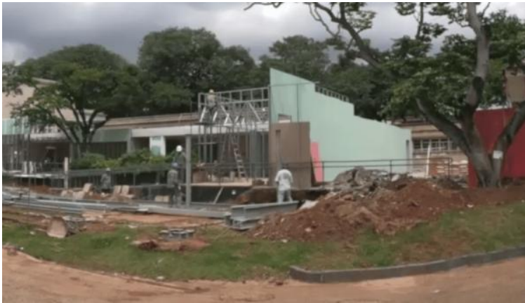
Figura 02: Casa Lite SP em fase de construção.
