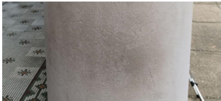
Figura 7- Foto de sujidade acumulada em pintura
